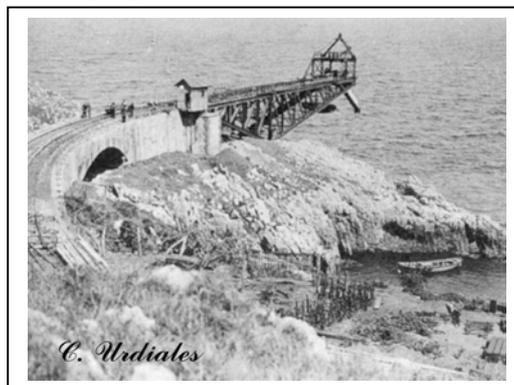
Por último, cada muelle llevará su vertedera para el mineral con el torno para maniobrarla, y el basculador para que el wagón pueda vaciar fácil y ligeramente.
